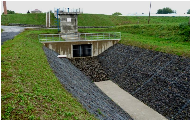
A Tápéi szivattyútelep vízdali elzárása
