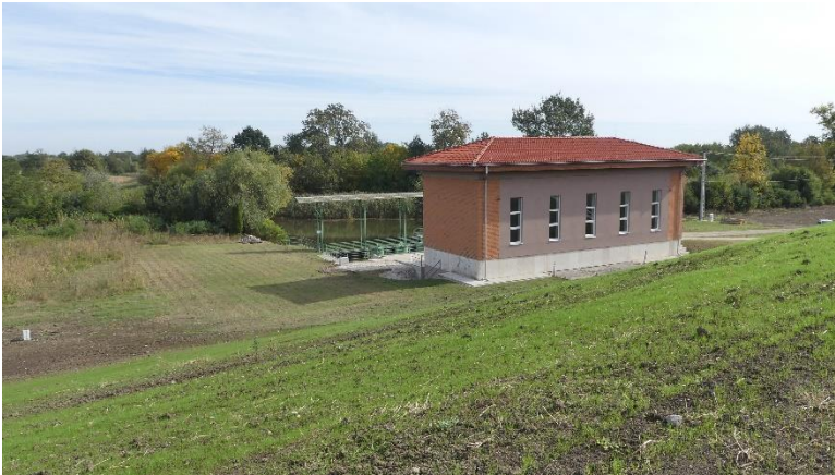
A felújított Mindszent II. jelű szivattyútelep
